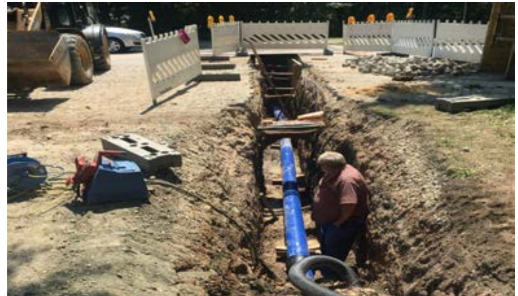
Anbindung an die bestehende Hauptleitung in der Martin-Luther-Straße
