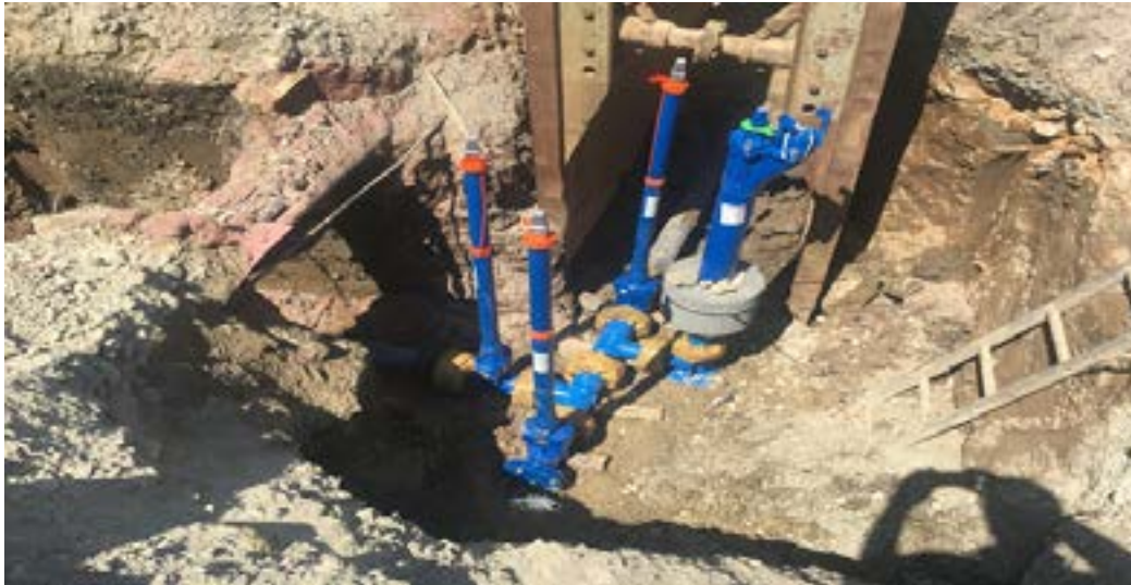
Neues Schieberkreuz in der Bieberbacher Straße
