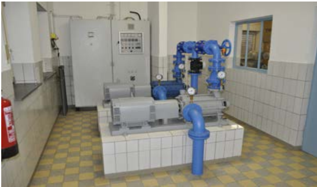
Pumpenraum in der Aufbereitung Sonnefeld
