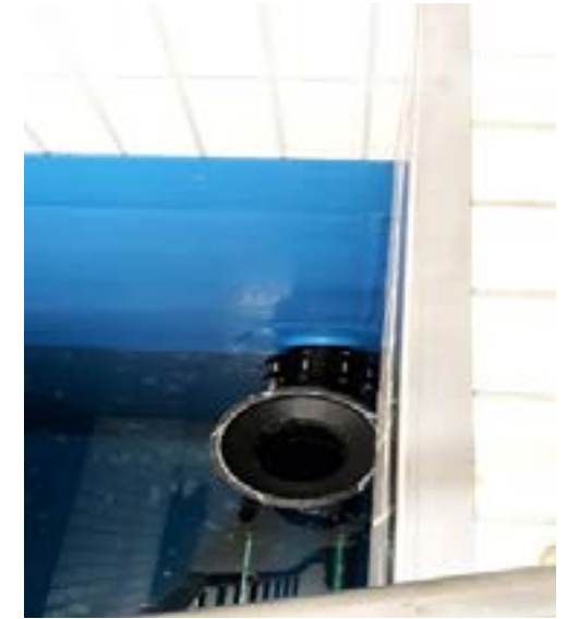
Beispielbild: Auskleidung neuer Vorlagebehälter
