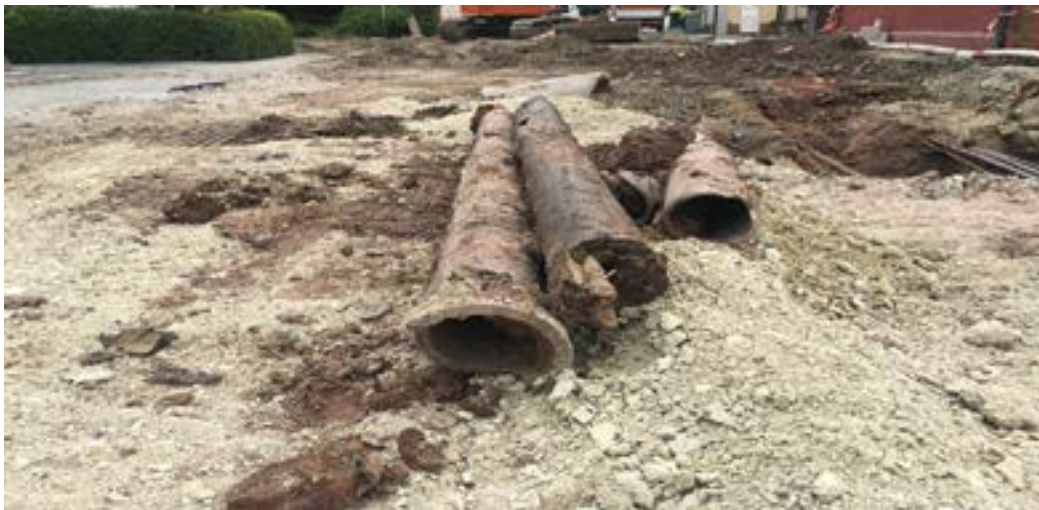
Alte Wasserleitungen aus der Bieberbacher Straße. Die Grauguss-Leitungen sind aus den frühen 60er Jahren. In der Mitte noch eine historische Holzleitung aus dem 18. Jahrhundert.
